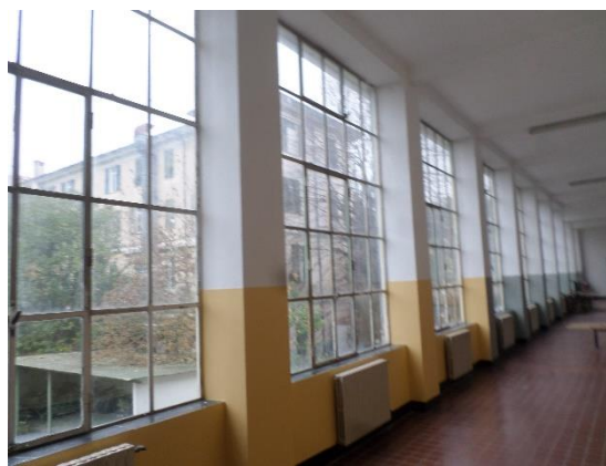
Figura 8.1 – Esempio del vecchio tipo di infissi presenti
