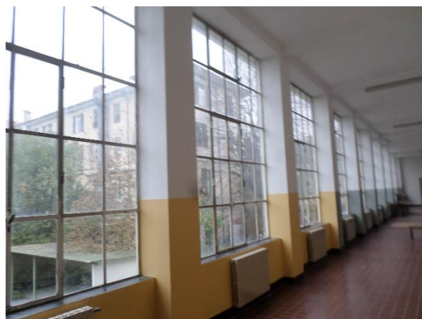
Figura 4.4 - Particolare dei serramenti I Piano Lato Est
