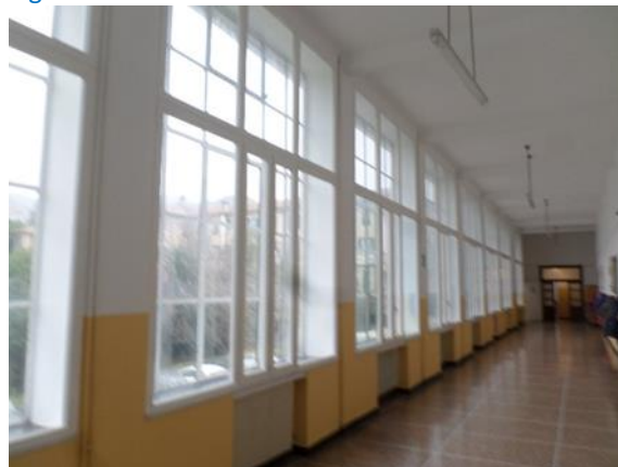
Figura 4.5 - Particolare dei serramenti I Piano
