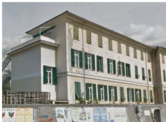
Figura 1.1 - Vista della facciata esposta a Sud -Ovest
